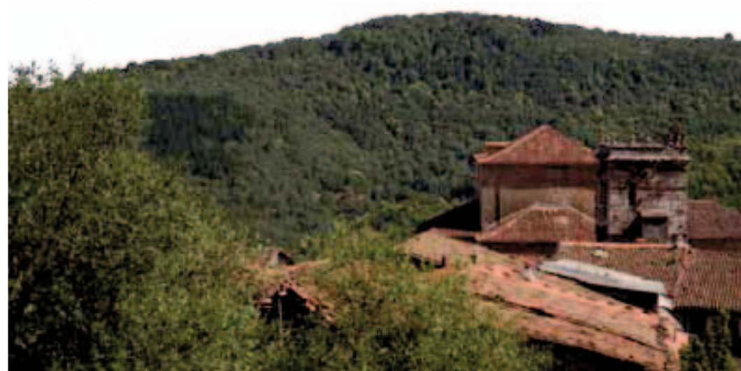
TEJADOS DEL CASERÍO CON LA TORRE DE LA IGLESIA
