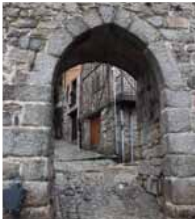
PUERTA DE LA VILLA, MIRANDA DEL CASTAÑAR
