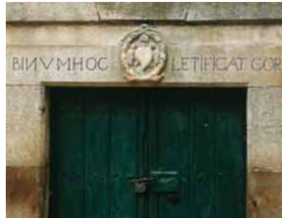
DINTEL DE UNA CASA
